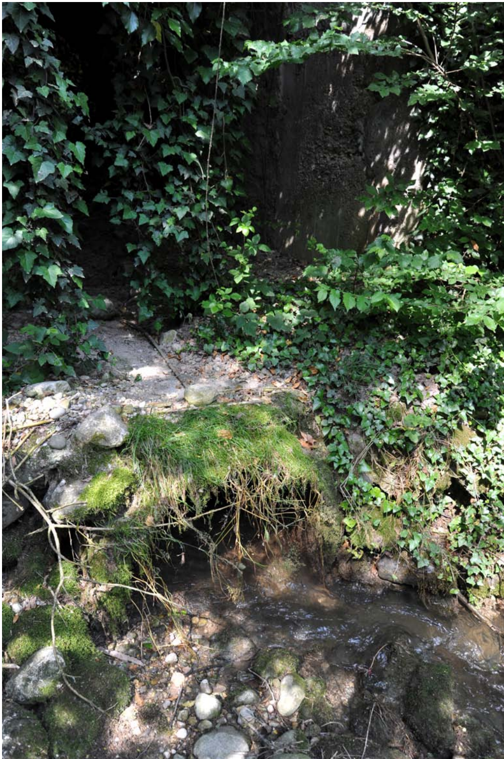
Foto 07 - torrente Vai fine tombinatura in uscita all'area (vista verso monte)
