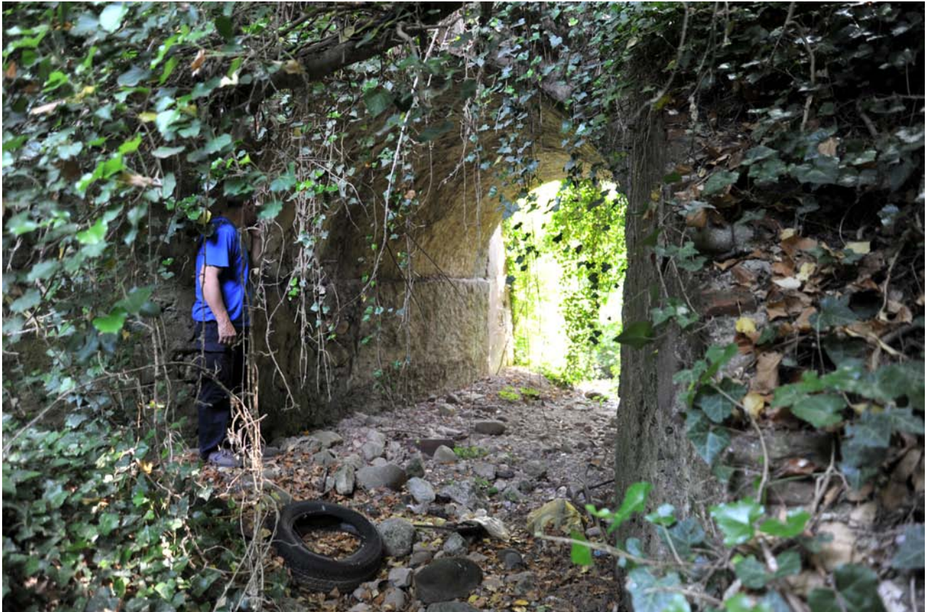
Foto 06 - torrente Vai fine tombinatura in uscita all'area (vista verso valle)
