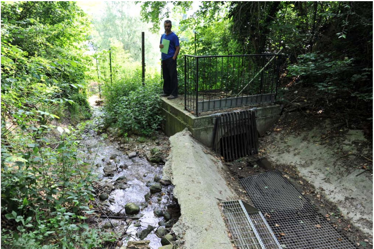
Foto 05 - torrente Vai inizio tombinatura in ingresso all'area (vista verso valle)
